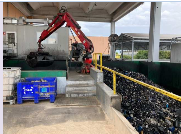
Area G, fase di lavorazione filtri olio
